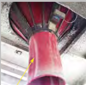
▲ Ein PUCEST ® Auslaufschlauch an einem PUCEST ® Auslauftrichter
