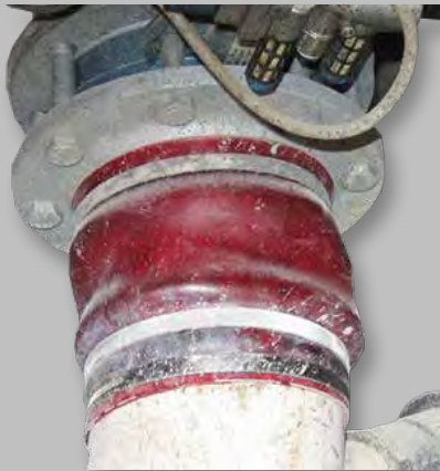
Übergabemanschette Wasserwaage/ Mischer
