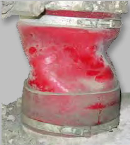
Übergabemanschette Zementwaage/ Mischer
