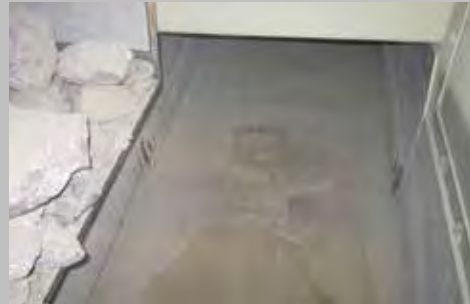
Ansicht 2 Förderrinne mit PUCEST ® Auskleidung, nach 4 Monaten Dauerbelastung
